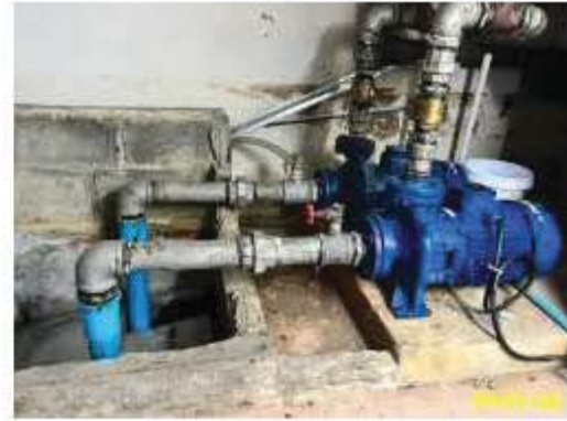
ถังเก็บน้ำใต้ดิน และเครื่องสูบน้ำ
